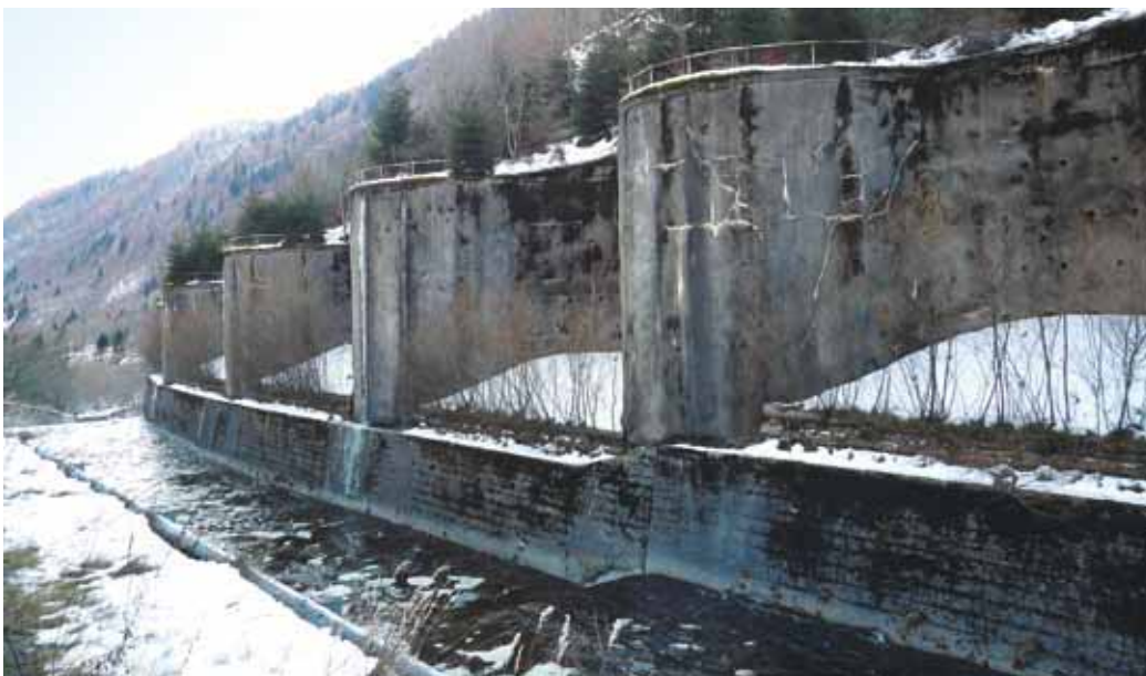
Fig. 151 – Località Laghetti. Parziale vista delle sistemazioni adottate negli anni '80 al piede della frana del Masareit. Ne hanno bloccato il movimento profondo che, periodicamente, portava l'accumulo a scendere verso la Bût, intasando il fondovalle e bloccandone i deflussi.
