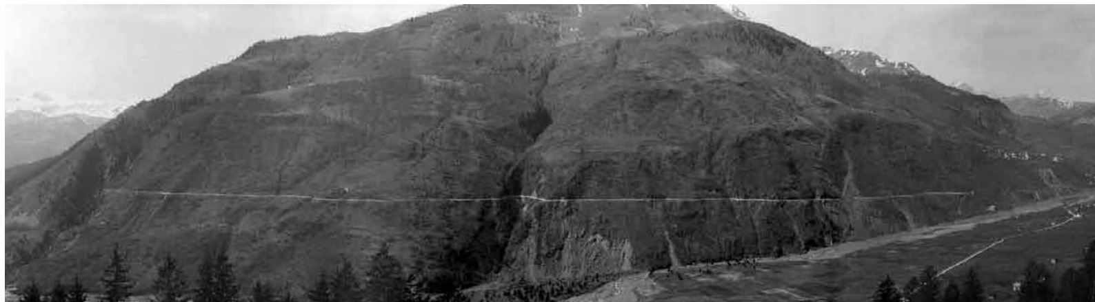
Fig. 7 – La condotta di adduzione della centrale di Enfretors lungo le pendici del Monte Tenchia.
