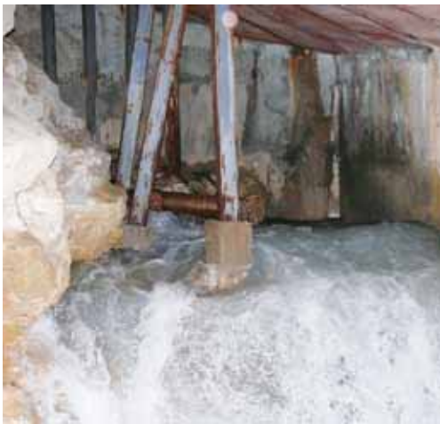
Fig. 14 – Immagine dell'interno dell'opera di presa del Fontanone.
