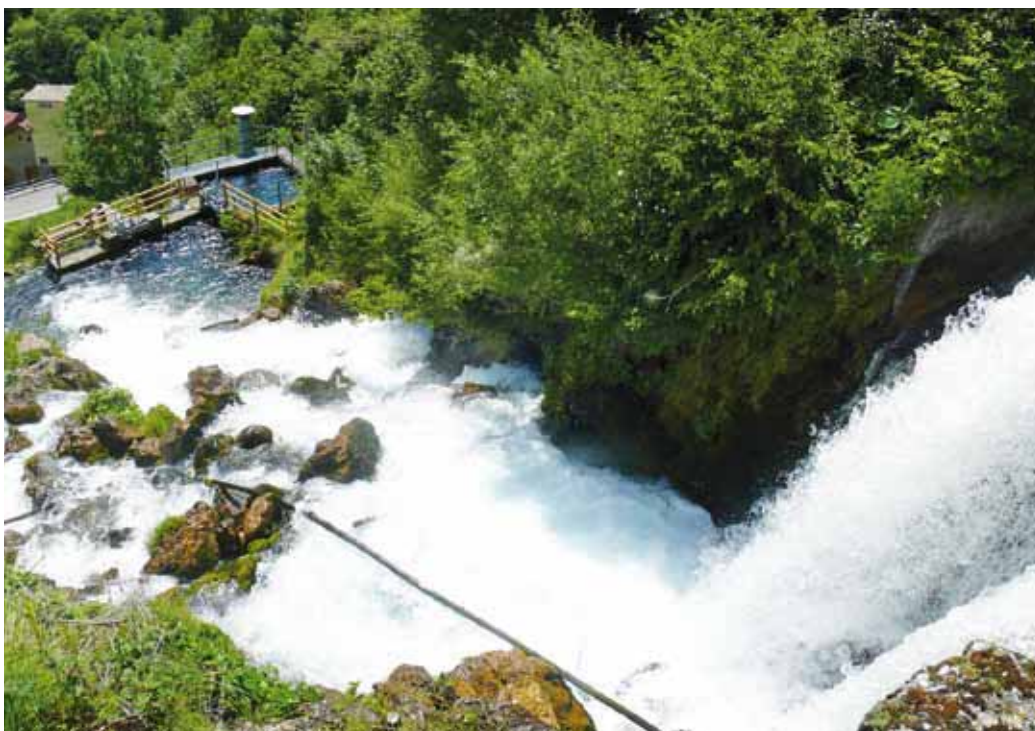
Fig. 20 – La cascata del Fontanone presso l'opera di presa (giugno 2010).
