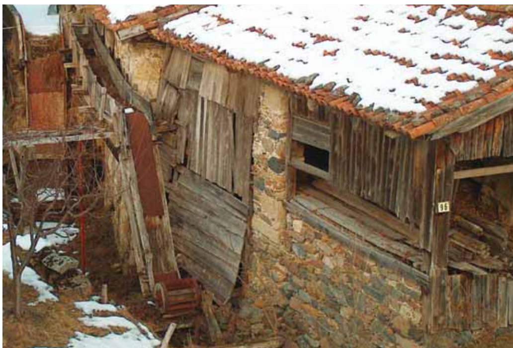
Fig. 16 – La segheria di Casteons con la doccia, un tempo appartenuta ai Silverio prima dell'intervento di restauro e risanamento conservativo.
