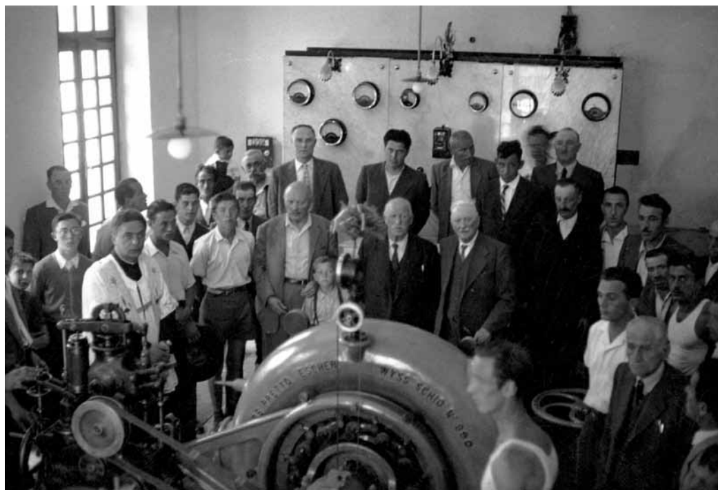
Fig. 11 - Fontanone - Dipendenti nella sala macchine (1948).
