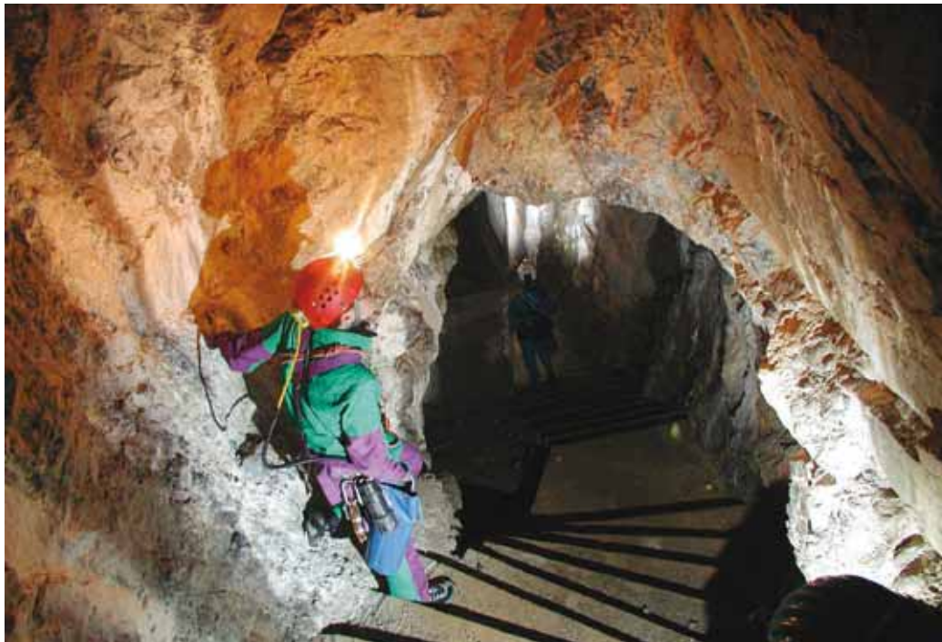
Fig. 4 – Grotta di Timau. Sono evidenti i segni degli interventi effettuati per adattare la cavità agli scopi bellici. (Foto Alberto Verrini).
