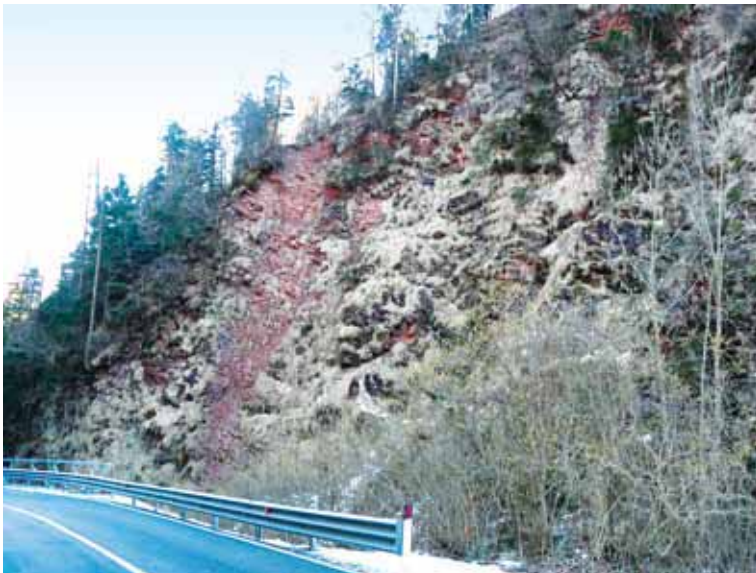
Fig. 61 – Sul fondo della Valcalda, incisa dal Rio Gladegna, sono esposti gli strati rossi dell'antica pianura di età permiana ( Arenaria di Val Gardena ).
