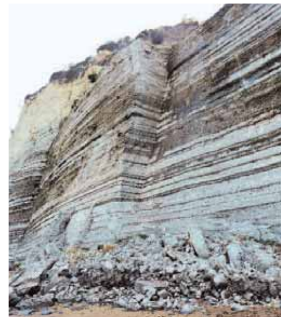
Fig. 279 - Ripida falesia localmente intaccata alla base dalla forza delle mareggiate, capaci di generare cavità che col tempo generano zone di debolezza nella parte più esterna della parete. Peroulades, Corfù NW (Grecia).
