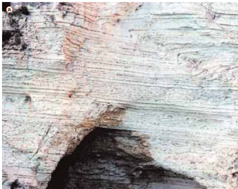
Fig. 172 - Queste immagini documentano le spettacolari deformazioni plastiche ( slump ) che costellano la falesia del Gargano, a S di Vieste (FG). Interessano una successione calcarea fittamente stratificata, spesso centinaia di metri e formata da calcari finissimi, i calcari cosiddetti micritici (la micrite è fango a composizione calcarea). Ad essi si intercalano frequenti livelli di selce spessi al massimo pochi centimetri. La selce, scura, contribuisce a rendere visibile la stratificazione e a farne apprezzarne le convoluzioni. La successione rocciosa si depositò in un mare mediamente profondo durante il Cretaceo.
