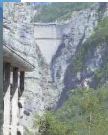
Fig. 118 (sotto) - La diga, ancora intatta pur se inutilizzata, ricorda che un tempo alle sue spalle si estendeva il Lago del Vajont. (Foto F. Finocchiaro).
