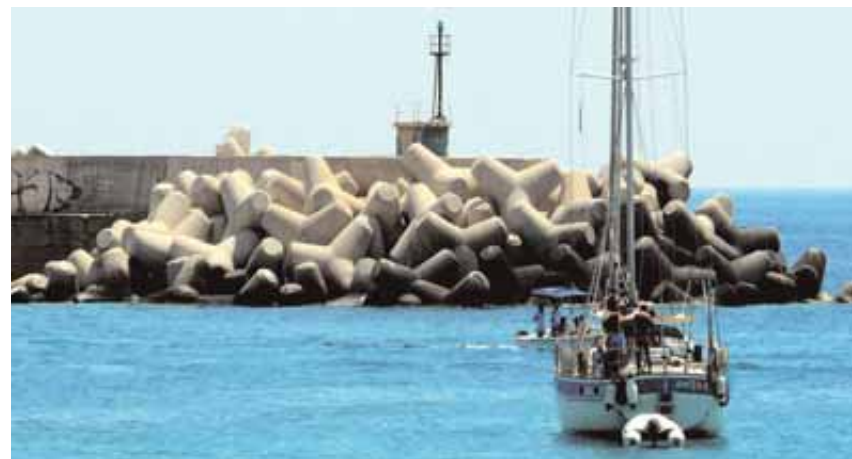
Fig. 281 - Una classica barriera foranea in grado di smorzare la forza delle mareggiate utilizzando i tetrapodi , forme in calcestruzzo (alte 1,5 m) che si incastrano efficacemente l'una nell'altra.
