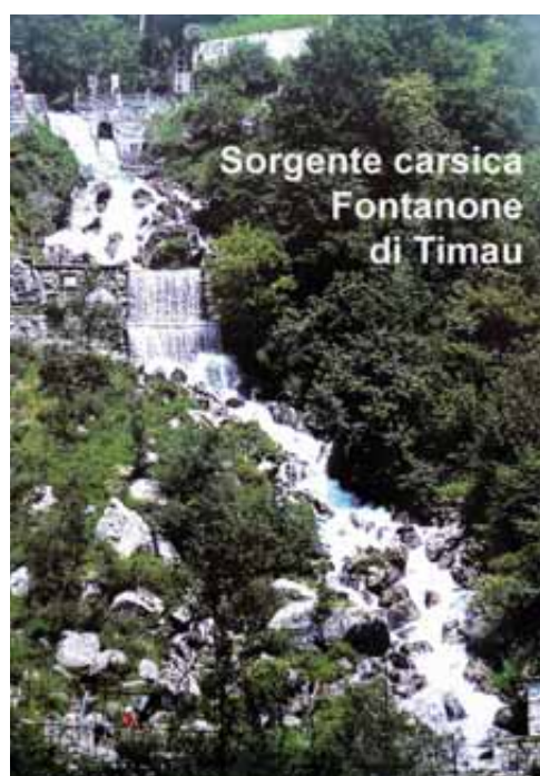
Fig. 164 – Il Fontanone oggi.
