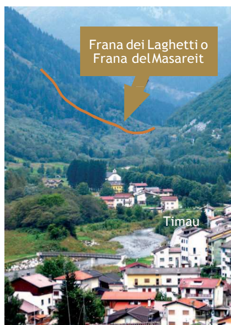
Posizione della Frana dei Laghetti.
